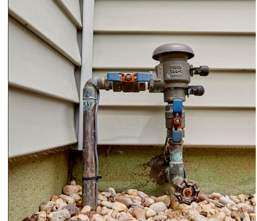
SPRINKLER SYSTEM BACKFLOW ASSEMBLY
