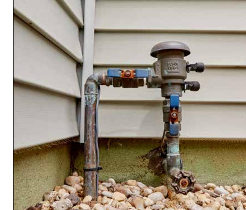
**SPRINKLER SYSTEM BACKFLOW ASSEMBLY**
